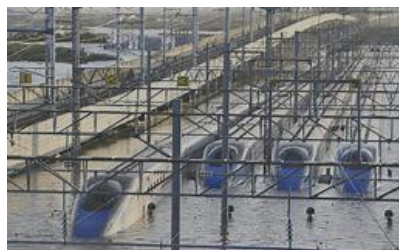
被災した長野車セの様子
