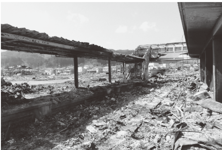
釜石線の津波と火災も発生し被災した陸中山田駅(4/1、佐々木研司盛岡支部委員長撮影)
