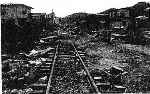
野蒜駅より仙台方の被災状況
